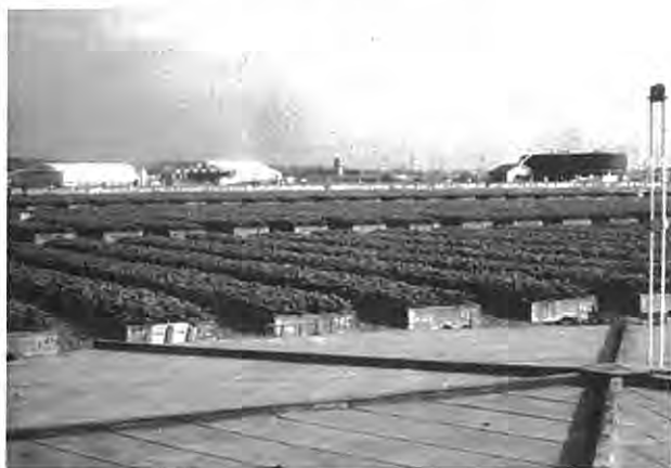
訳者注：整然と並ぶれき耕ベッド：一番手前が下段である。右奥に見える黒い丸いものが培養液貯蔵用のタンクである。
