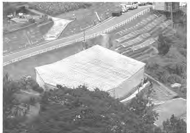
図1 傾斜度20°の圃場に建設した平張型傾斜ハウス (徳島県東みよし町)
