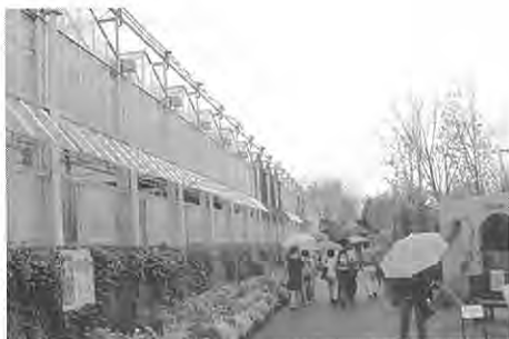
図1 浜名湖花博「花みどり未来館」の外観 花博会場で最も大きな温室（3,000m 2 ）。高軒高フェンロー型温室で、外部水平遮光幕が設置されている。
