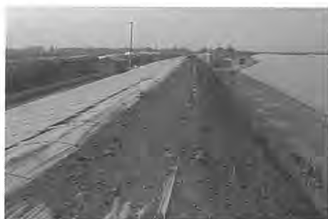
図2 日光温室外部
