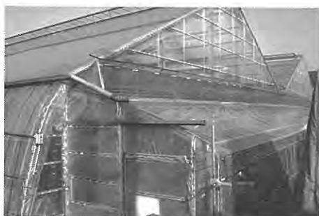
図1 小門さんのハウス 大屋根ハウスの2連棟, 妻面と側面に張り出し部を設けて通気性をよくしている。
