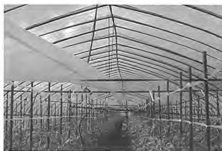
図4 ボトキラー専用ダクト散布器設置ハウス
